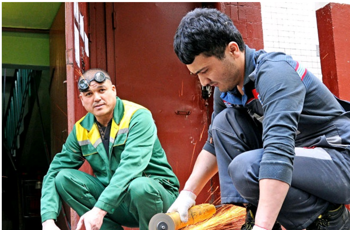
Жилой дом отремонтируют в поселении Щаповское. Фото: архив
