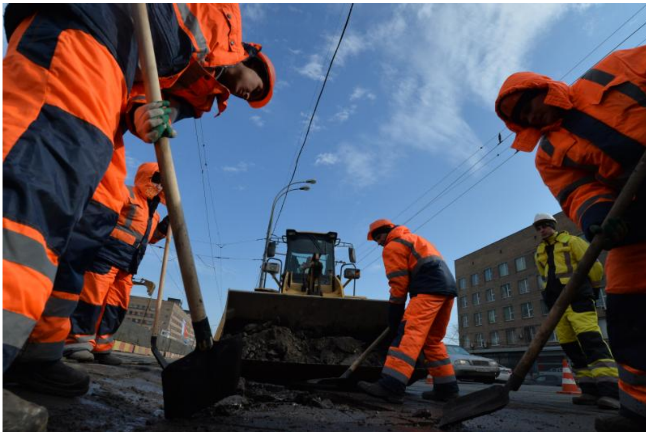
Участок дороги в Кокошкино отремонтируют в первой половине следующего года. Фото: Александр Казаков
