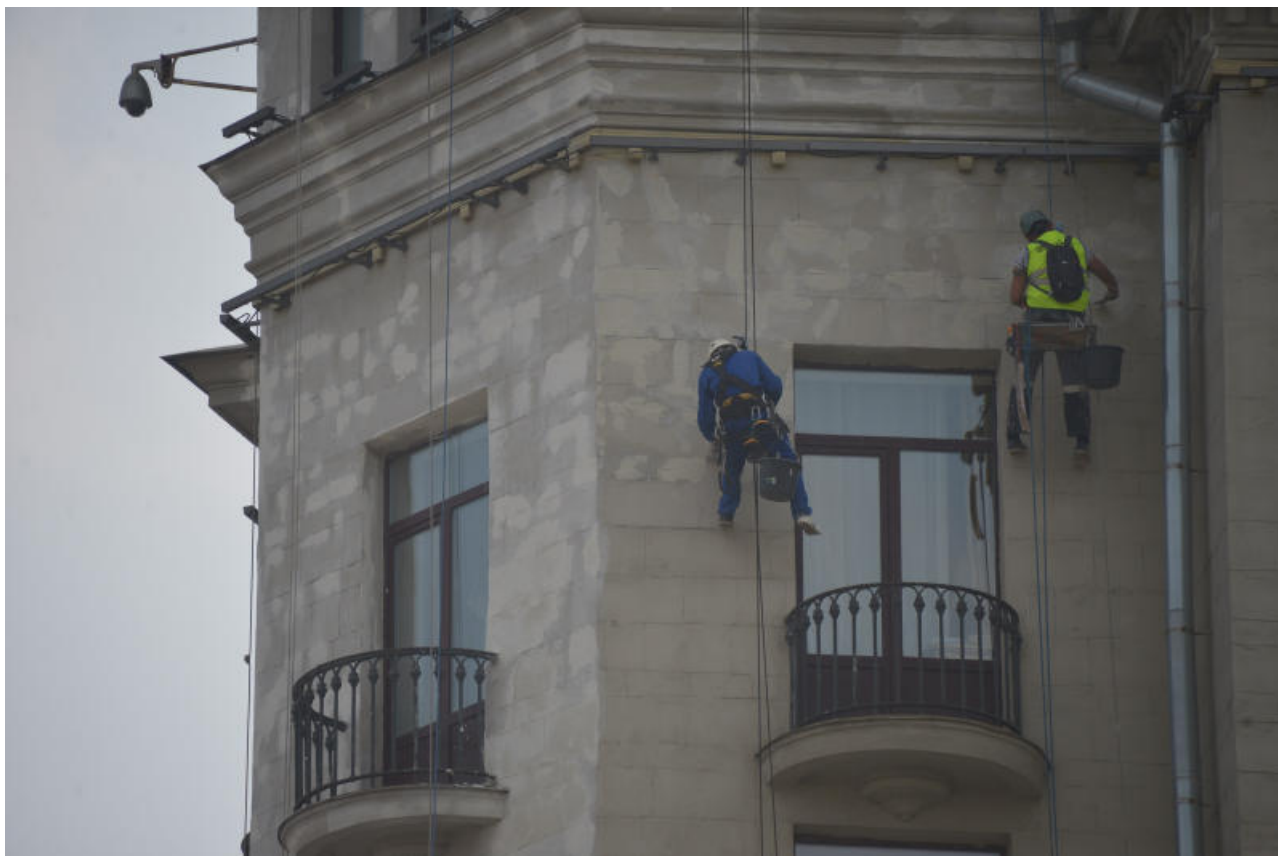
Ремонт внешних фасадов жилых домов завершат в Кокошкино. Фото: архив
