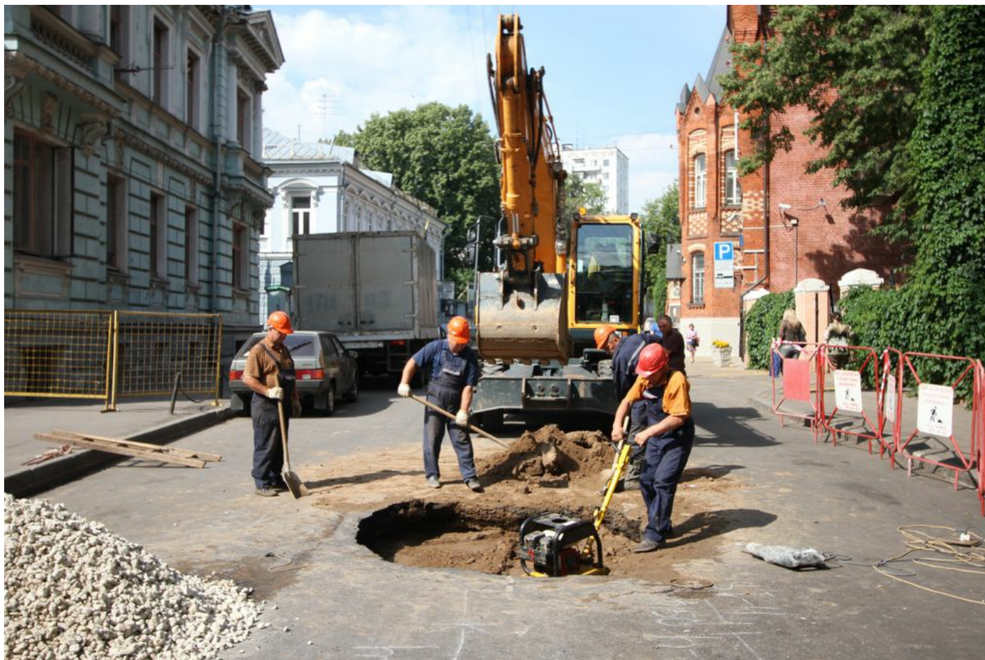
Плановый ремонт дорог в Кокошкино выполнили на 40 процентов, Фото: архив
