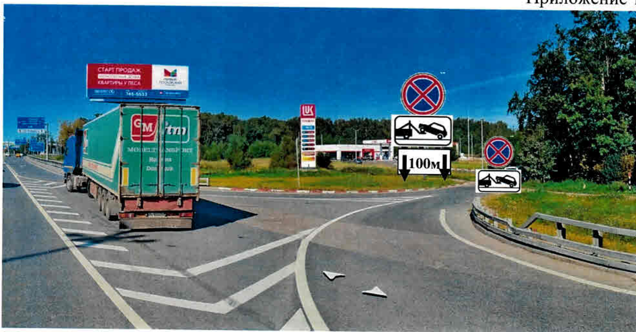
16. Установка дорожных знаков 3.27 «Остановка запрещена» со знаками доп. информации 8.24 «Работает эвакуатор» и 8.2.4 «Зона действия» по адресу: Киевское шоссе, 28 км, съезд к автозаправочной станции «Лукойл», п. Московский.
